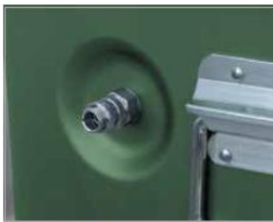
Клапан для наполнения инертным газом
